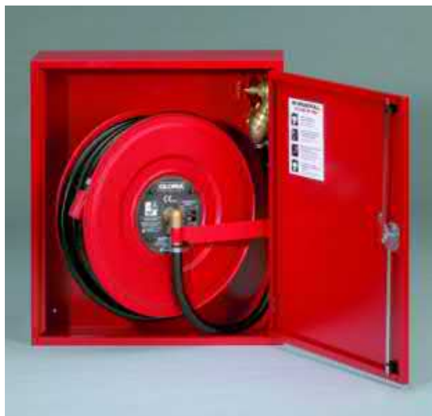
Рисунок 1 – Рукавная катушка давления подсоединена к клапану пожарному запорному
