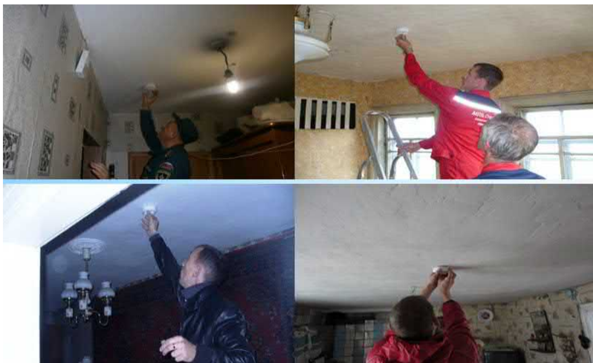
Рисунок 2 – Фотографии, по установке автономных дымовых пожарных извещателей
